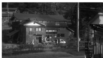
事務所全景(築110年)
